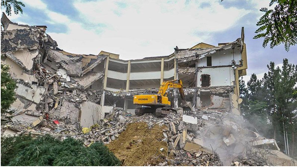
Görsel 3. Dicle Üniversitesi Rektörlük Binasının Yıkım Anı, Doğan Haber Ajansı (2023)
