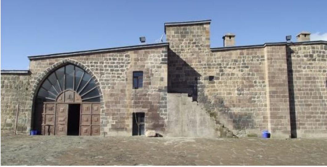
Fotoğraf 2: Restorasyon Sonrası Ana Yapı Girişi (Gelişkan, 2015)
